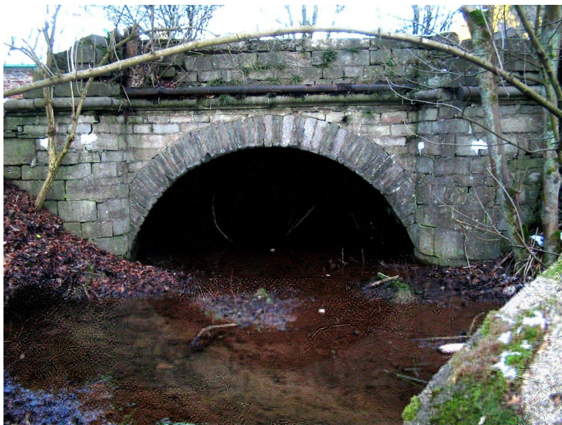
Une arche de l'ancien Pont d'Marlire . Elle subsiste (obstruée à l'arrière) à côté du parking du bassin de natation. Les anfractuosités entre les moellons hébergent des invertébrés.
