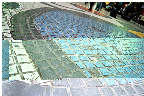
Detall del mosaic amb peces de color blau deteriorades
