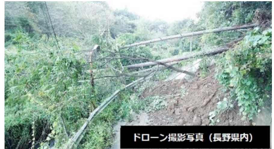
台風19号：電柱倒壊・倒木
